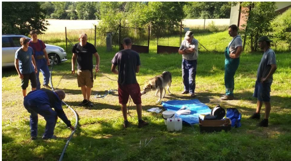
Výměna čerpadla ve vodovodním vrtu
