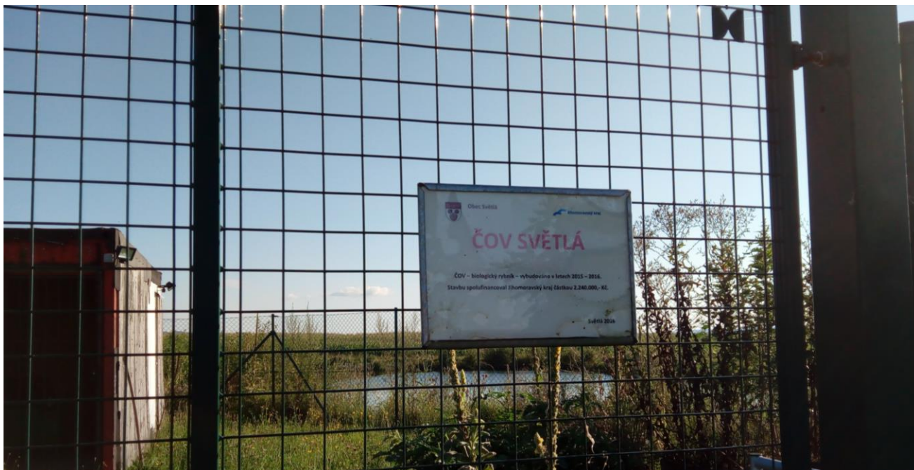
Obrázek 13: ČOV v obci Světlá 17
