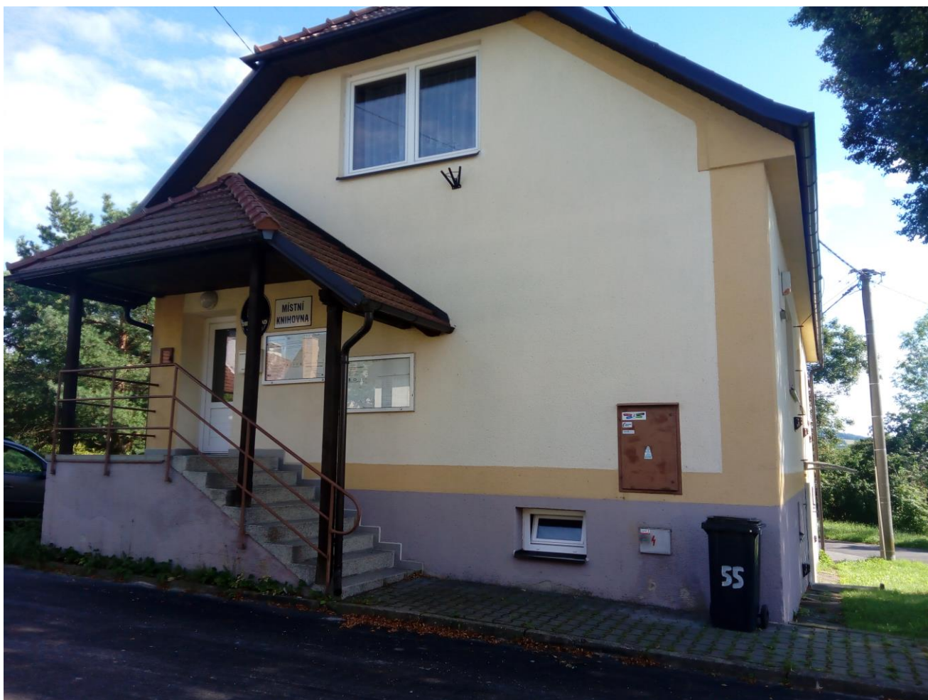
Obrázek 19: Budova obecního úřadu 23
