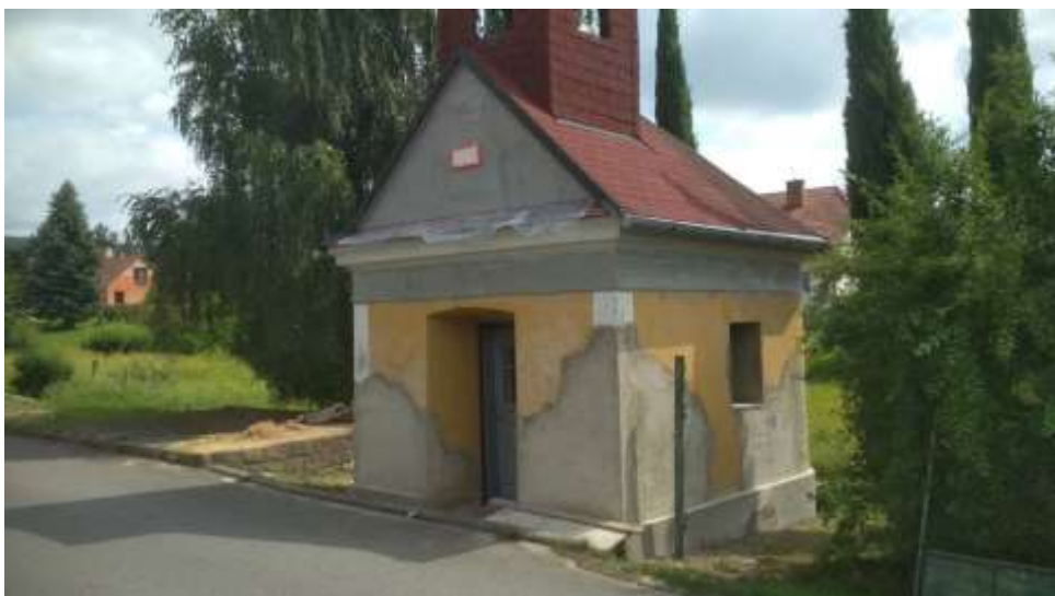
Oprava kapličky červenec 2021
