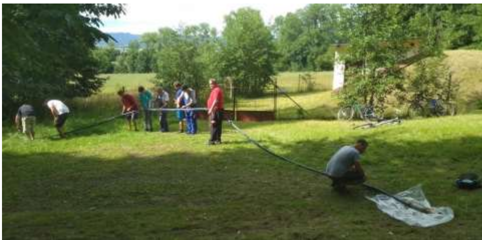
Výměna čerpadla ve vodovodním vrtu 4.8.201
