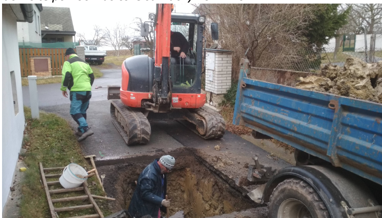
Oprava poruchy vodovodní přípojky v hodní části obce - 22.11.2021
