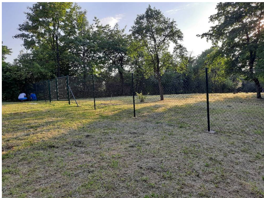
Stavba plotu u vyletiště - srpen 2022
