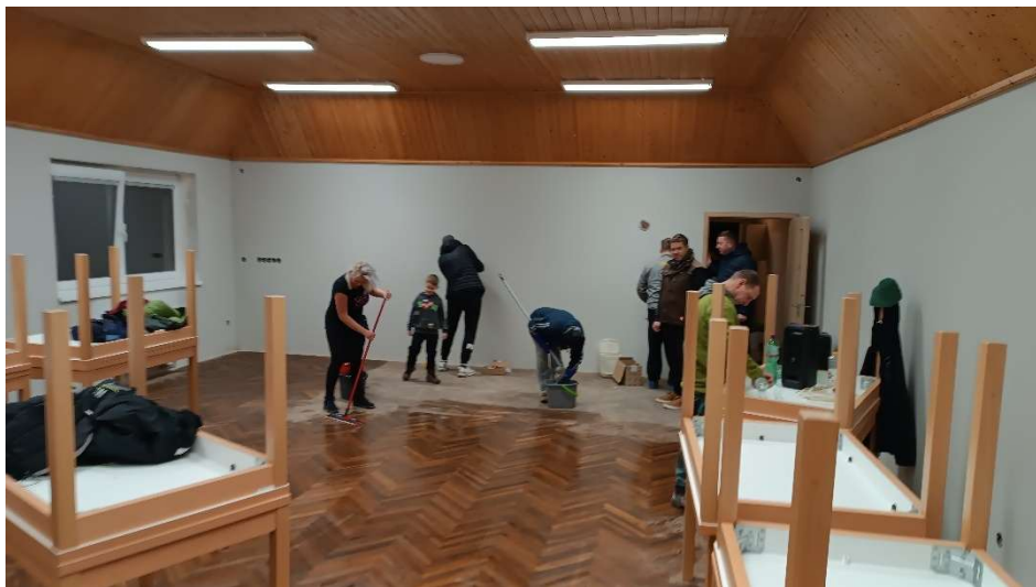
Úklid sálu po její rekonstrukci (leden 2025)
