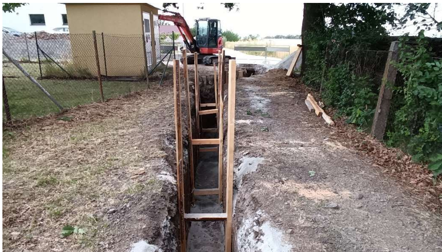
Výkopy pro zokruhování místního vodovodu.
