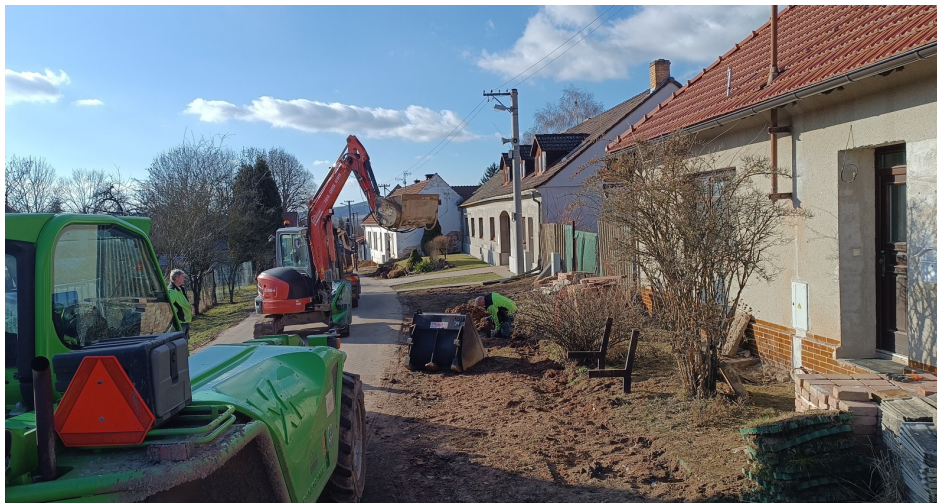
Instalace sloupů veřejného osvětlení u kapličky
